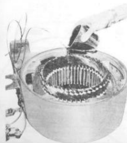
Fig. 1.56. — Impregnación a mano de arrollamientos con barniz a base de resina «epoxy». El estator se coloca en posición horizontal, con los terminales hacia abajo. Los arrollamientos están a unos 130°C. Se vierte barniz hasta que se solidifica el que ha llegado al extremo de los terminales (3M Company).
