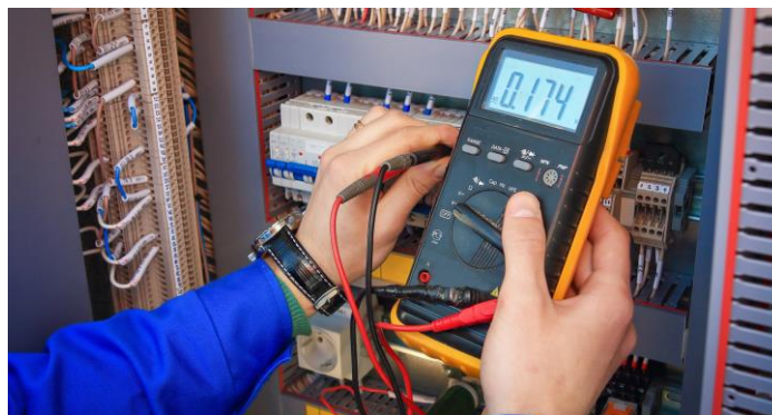
Prueba de continuidad de circuito sin energía eléctrica
