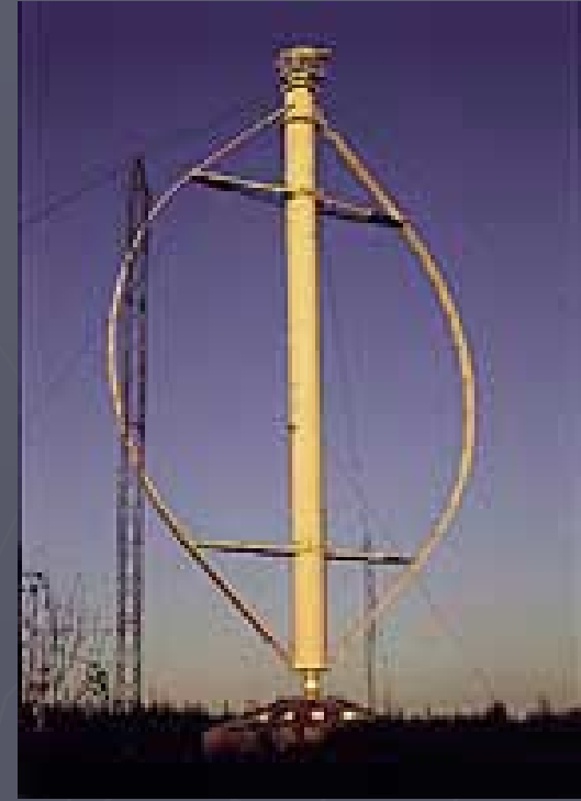
“Eole C”, un aerogenerador de eje vertical Darrieus de 4200 kW, con un diámetro de rotor de 100 m, en Cap Chat, Québec (Canadá). Esta máquina (que es el aerogenerador más grande del mundo) ya no está operativa.
