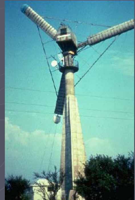
El aerogenerador Gedser (200 kW, 24 m)
